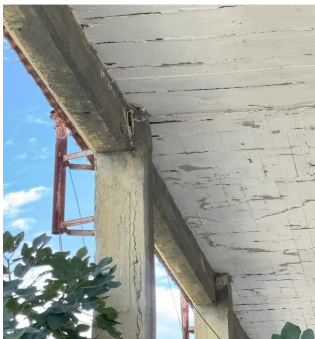
Φωτογραφία 6: Οι κόμβοι δοκού-υποστυλώματος και το υποστύλωμα της ανατολικής όψης του πλαισίου τμήματος Β του κτιρίου 1.
