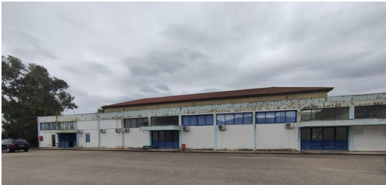
Φωτογραφία 1: Κτίριο 1-Αίθουσες Διδασκαλίας
