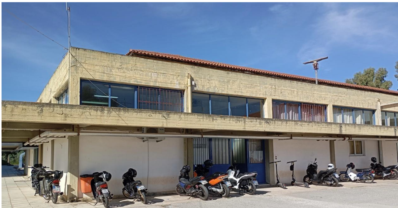
Φωτογραφία 3: Νοτιοανατολική λήψη του τμήματος Α του Κτιρίου 1.
