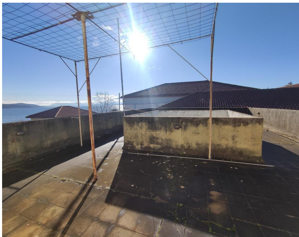
Φωτογραφία 16: Εξωτερικό του κτιρίου 8 – Ταράτσα.
