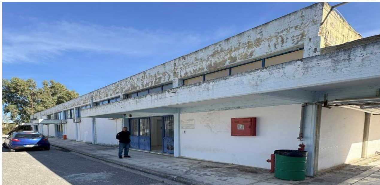
Φωτογραφία 2: Δυτική όψη του τμήματος Α του Κτιρίου 1.
