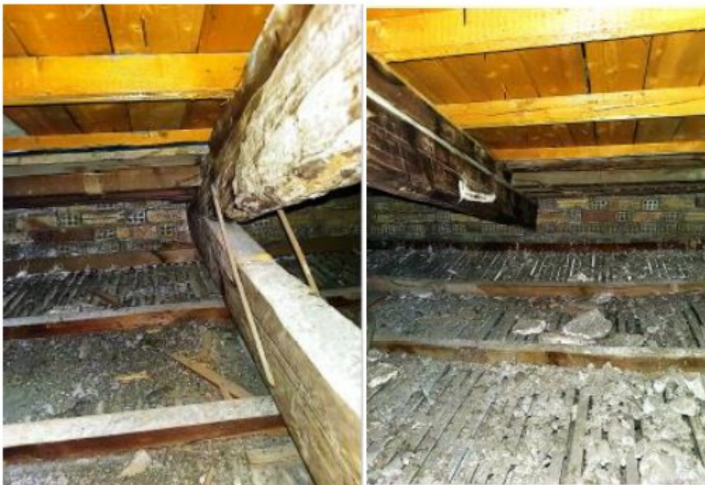
Εικόνες 1 και 2. Εσωτερικό κεραμοσκεπής
